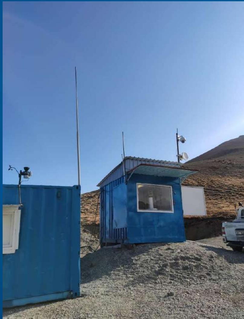
Геомеханическая наблюдательная станция, оснащенная системой Leica, радаром непрерывного наблюдения за бортами карьера и отвалов
