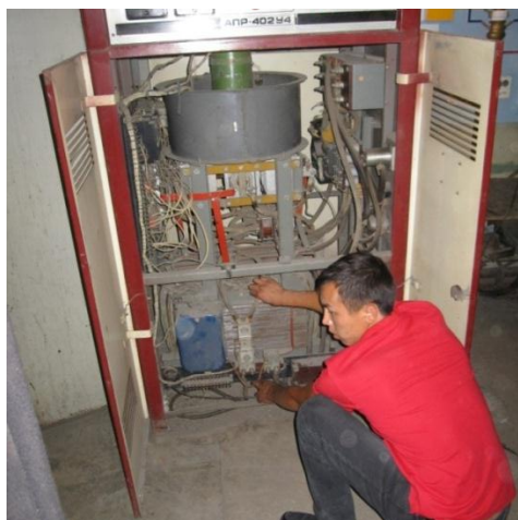
Восстановление и ремонт силовых кабелей установки
