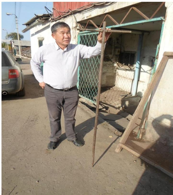
Рис.3.12. Направляющая, изготовленная из цельного прутка, имеющая  $d=20\text{мм}$
