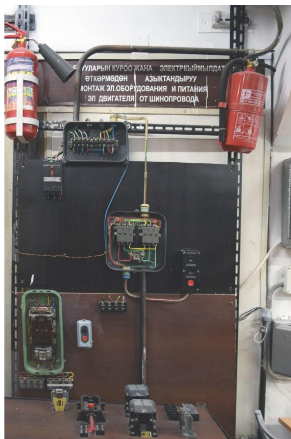
Стенд. Монтаж электрического оборудования и питания электрического двигателя от шинпровода. 5/2036.
